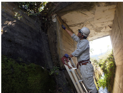
写真 1. 梯子による点検
