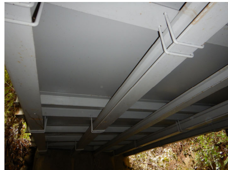
写真2. 床板補修例 炭鉱3号橋 (錆止剤塗布)
