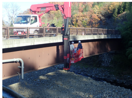
写真 2. 橋梁点検車による点検
