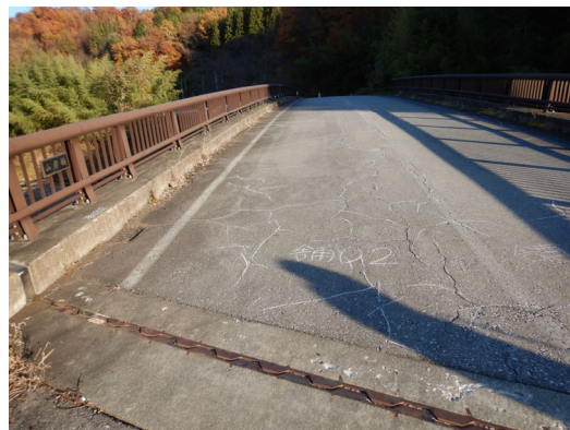
健全度Ⅱ：山岸橋
