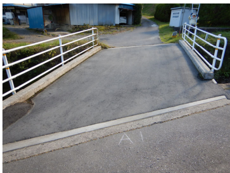
写真3. 橋面補修例 向山2号橋 (舗装更新)
