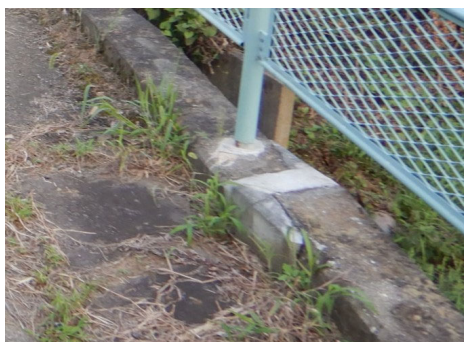
写真1. 地覆修繕例 大法寺橋 (部分補修)
