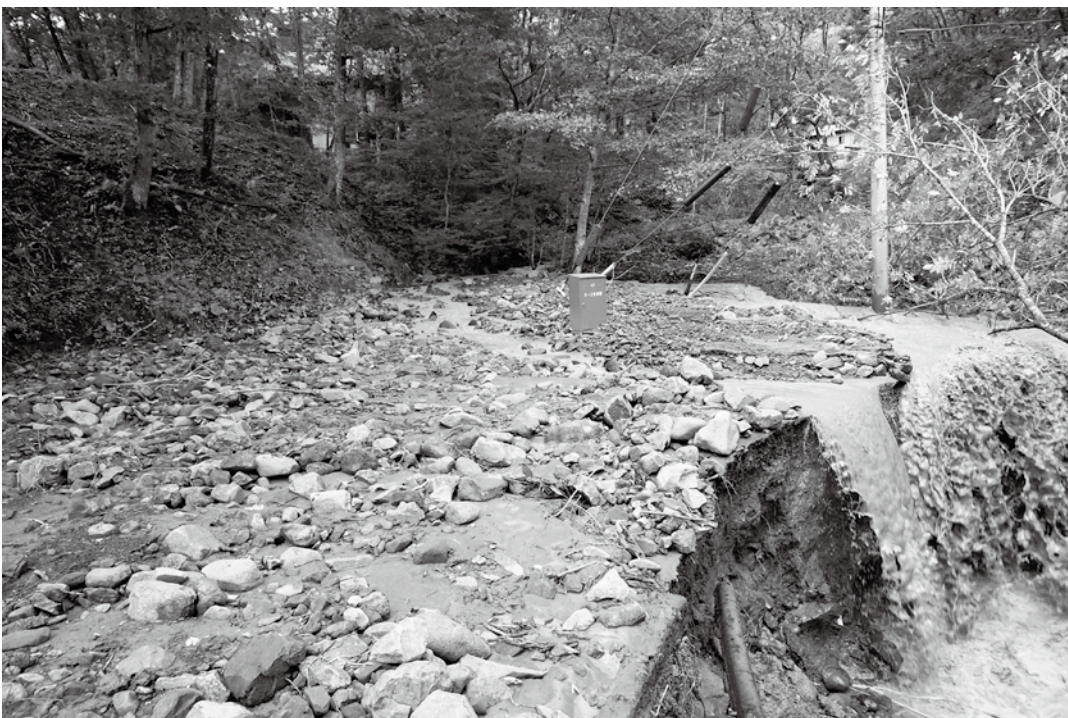
令和元年 19号台風による被害
