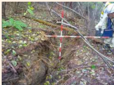
開口幅1m、落差1m程度の開口亀裂が発生。
