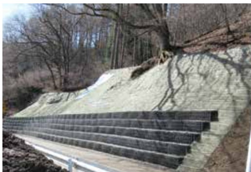
道路災害 復旧状況
