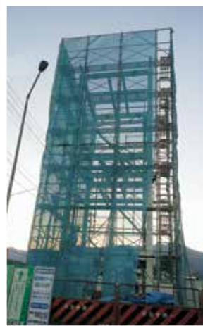
建設がすすめられている(仮称)防災発電タワー
