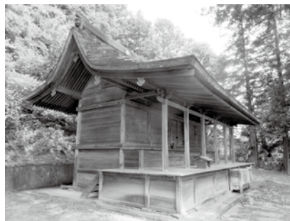
屋根の葺き替え時期を迎える 県宝日吉神社本殿
